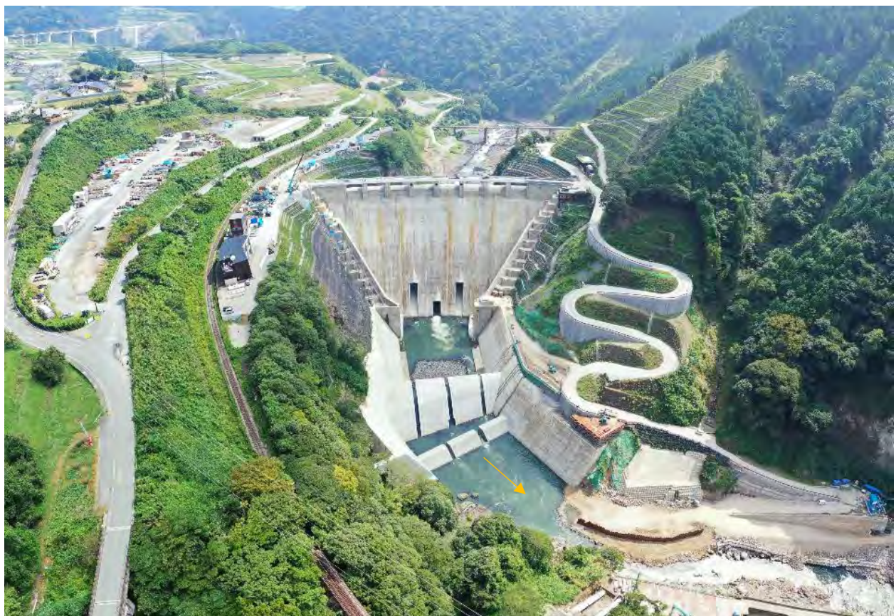
阿蘇立野ダム本体(下流より上流を望む)
