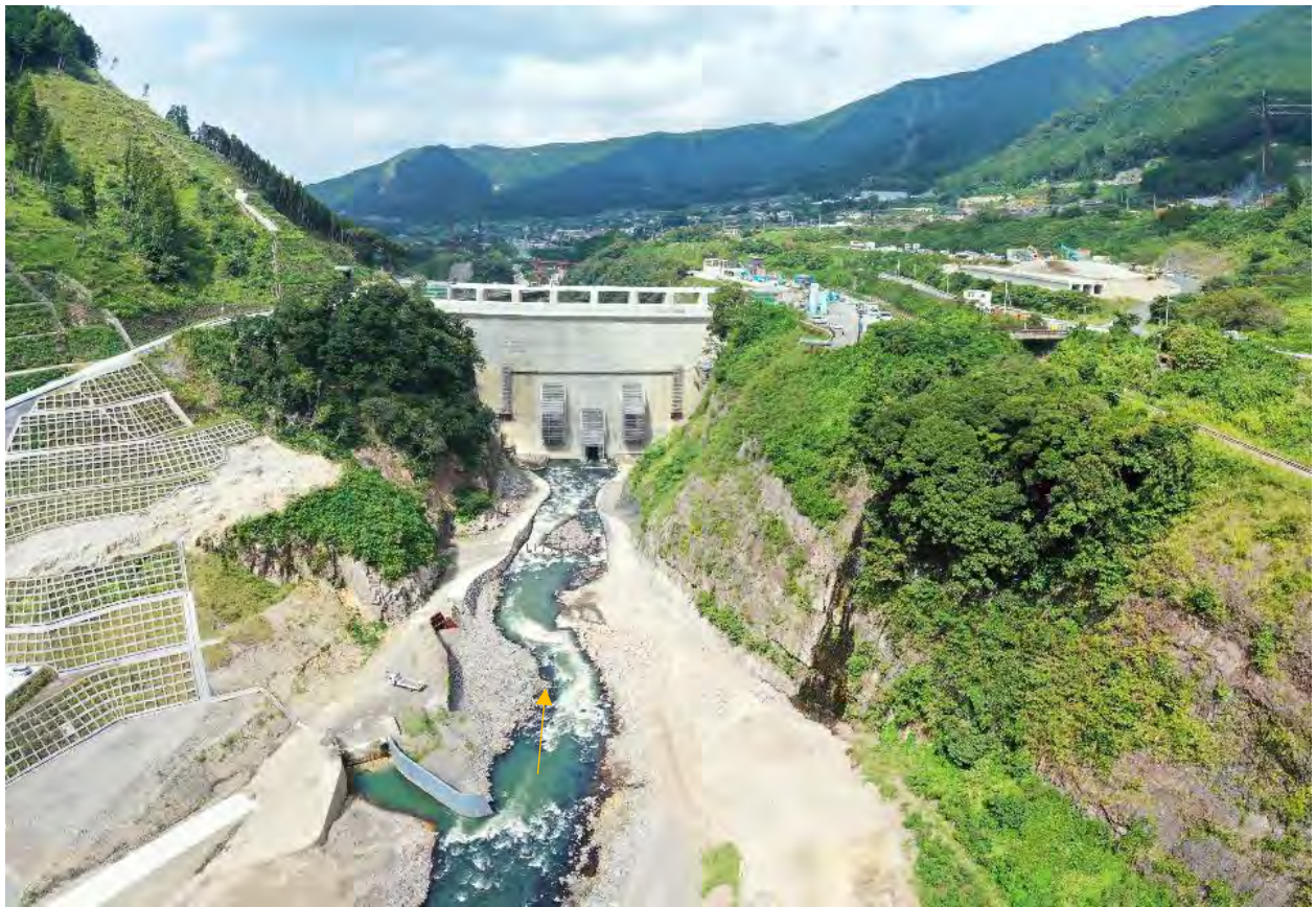
阿蘇立野ダム本体(上流より下流を望む)
