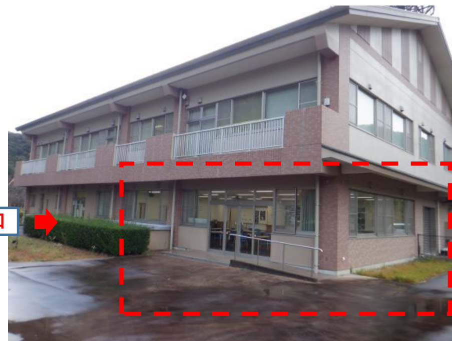
管理所外観 (赤枠内:提供エリア)
