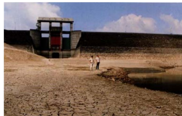
干上がった寺内ダム(平成6年渇水)
