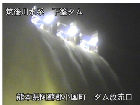
下釜ダム最大放流量 1,340\text{m}^3/\text{s} 放流状況 (7月8日0:30)
