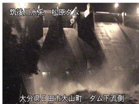
松原ダム最大放流量 1,100\text{m}^3/\text{s} 放流状況 (7月8日0:20)
