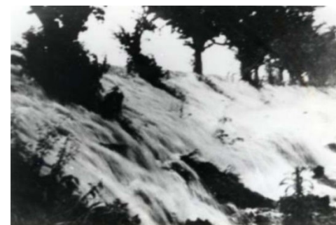
久留米市東櫛原の堤防からの越水状況 （昭和28年6月洪水）
