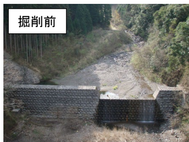
堆積土砂撤去前後の状況(蕨野谷貯砂ダム) ※H19年度撮影
