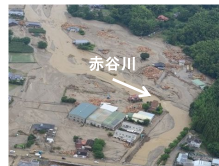
大量の土砂や流木による被害を受けた赤谷川 （平成29年7月洪水）
