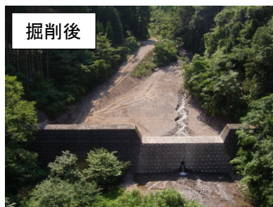
堆積土砂撤去前後の状況(蕨野谷貯砂ダム) ※H19年度撮影
