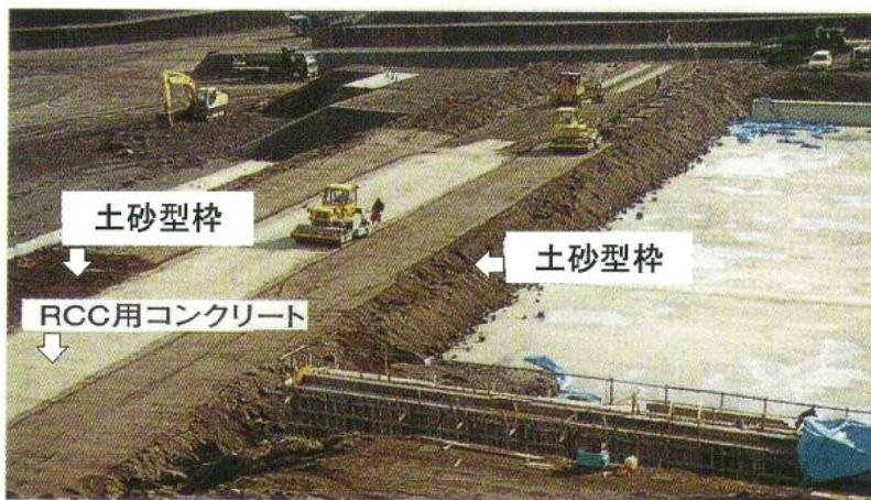
写真-2 土砂型枠を用いた本体部の建設
