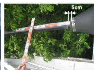
写真2、3 ケーブルのよれ・抜け
