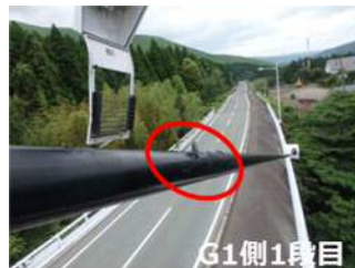
写真4 ケーブルの損傷状況
