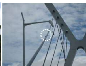
写真2、3 ケーブルのよれ・抜け
