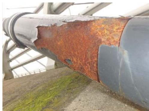
写真3 ケーブル定着部付近の損傷
