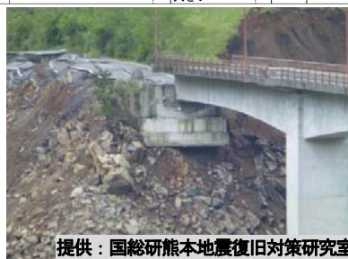
図-4 落橋を免れた阿蘇長陽大橋
