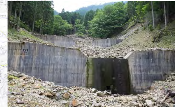
土砂を捕捉した治山ダム
