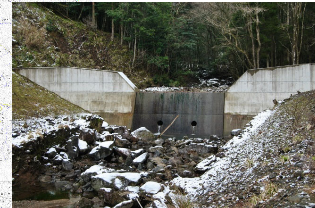
土砂を捕捉した治山ダム
