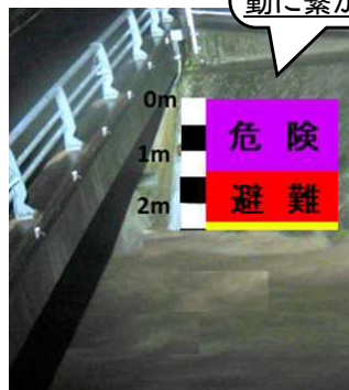
[設置後（増水時）]
