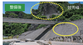
堤防護岸に、競秀峰と同じ凝灰岩を使用
