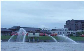
【消防車による放水噴出作業（三ノ丁地区）】
