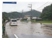
【8号アークの耶馬溪橋の水没状況（本耶馬溪地区）】
