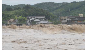
【8号アークの耶馬溪橋の水没状況（本耶馬溪地区）】
