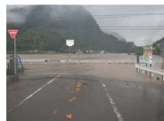
【水没・冠水した田畑や道路（下笠地区・伊瀬）】
