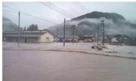
完全に冠水してしまった下部交差点（鳥居地区）
