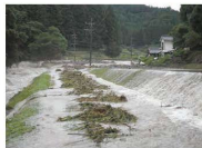
【氾濫した奥木川（倉谷地区）】
