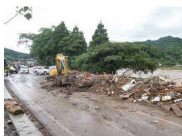
【国道212号外付けの状況（本耶馬溪地区）】
