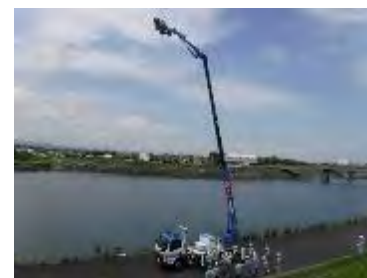
○照明車 現地配備状況(一例)
