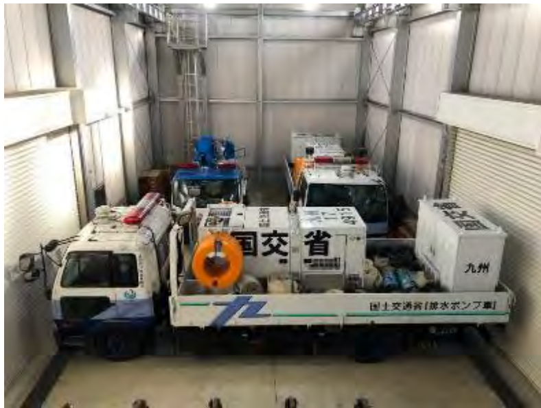
平成大堰予備ゲート庫
