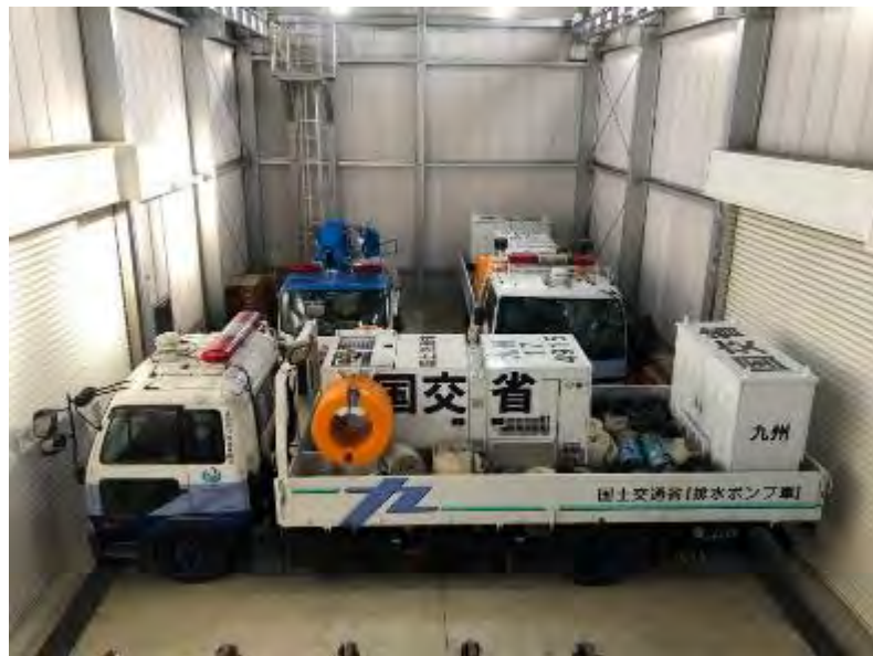
平成大堰予備ゲート庫
