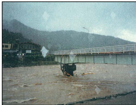
平成5年9月洪水（青地区、橋の流出）
