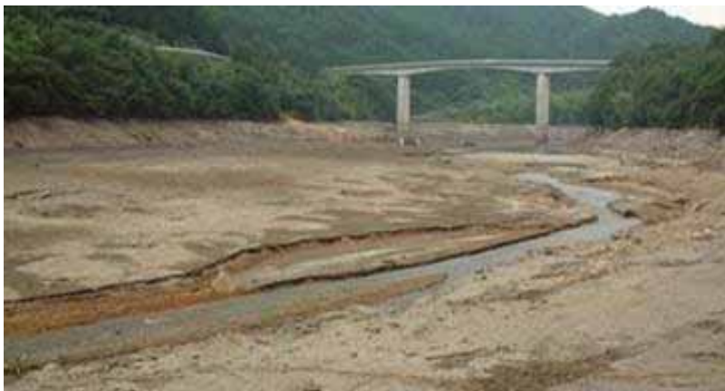
耶馬溪ダムの渇水状況（平成17年）
