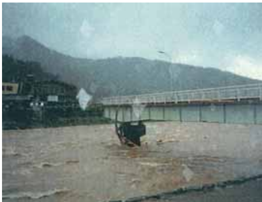
青地区（橋の流失）出水状況 （平成5年9月）
