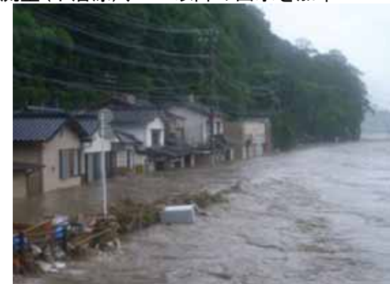
山国川中流部の浸水状況 （平成24年7月）
