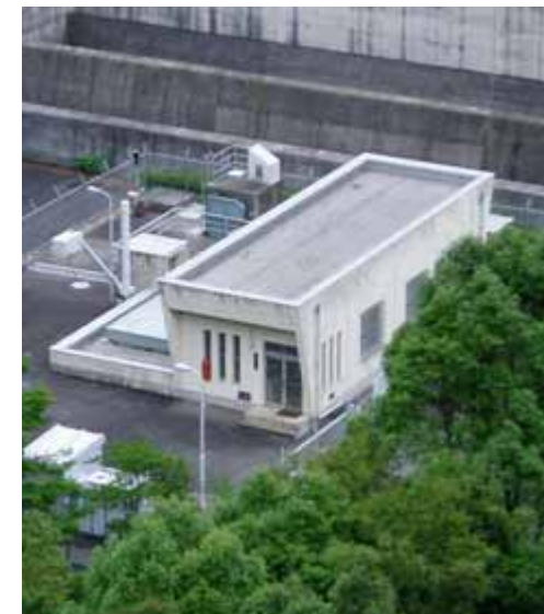
耶馬溪発電所
