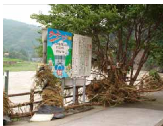
写真 1.2.5 青地区出水後の状況 (平成 19 年 8 月)
