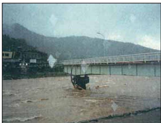
写真 1.2.2 青地区（橋の流失）増水状況 (平成 5 年 9 月)
