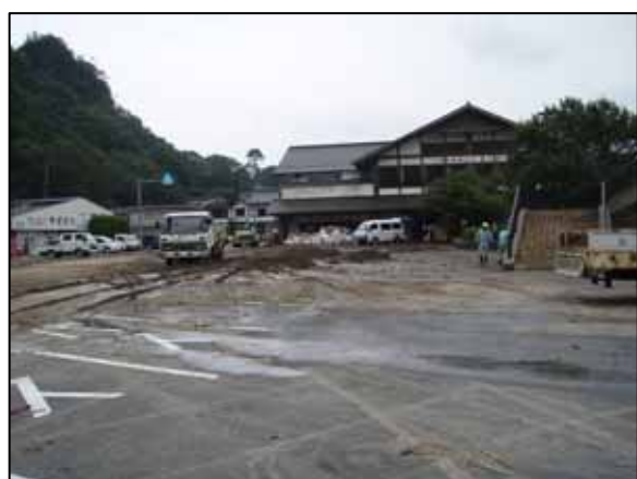
写真 1.2.4 青地区出水後の状況 (平成 19 年 8 月)
