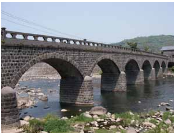
写真 2.3.7 耶馬溪橋（オランダ橋）
