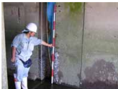
写真 2.1.3 水門（樋門樋管）等の点検状況
