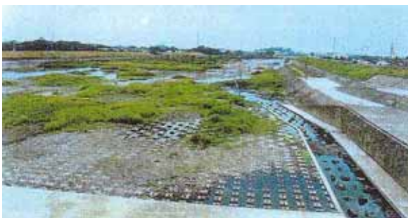
写真 2.2.1 平成大堰下流の渇水状況 (平成 13 年)
