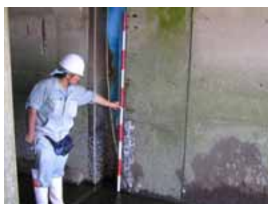
写真 2.1.3 水門（樋門樋管）等の点検状況
