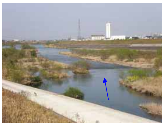
土砂撤去及び樹木伐採後
