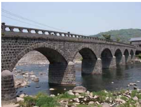
写真 2.3.7 耶馬溪橋（オランダ橋）
