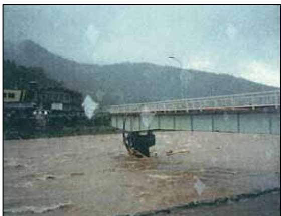
写真 1.2.2 青地区（橋の流失）増水状況 (平成 5 年 9 月)
