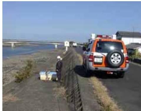
写真 4.3.1 河川巡視状況
