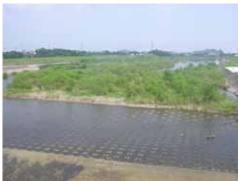
写真 2.1.1 土砂堆積及び樹木繁茂状況
