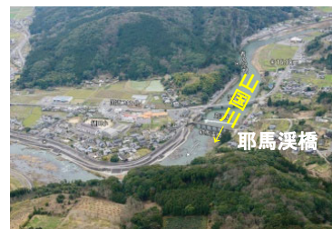
耶馬溪橋付近(16.0km)
