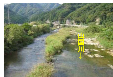
江洲橋付近(県管理区間)
