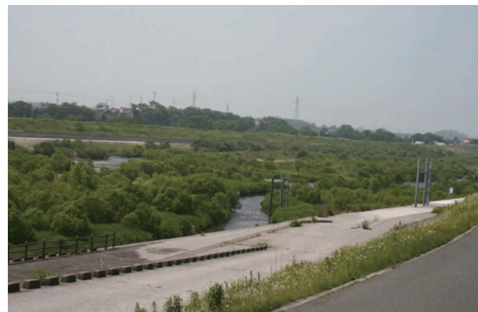
河道内の樹木繁茂状況
