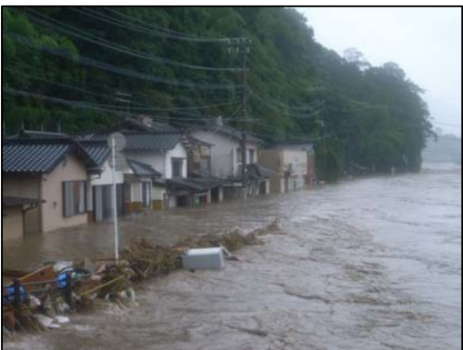
写真 1.2.6 山国川中流部の浸水状況 (平成 24 年 7 月)
