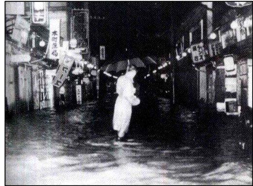
写真 1.2.1 浸水状況(昭和 19 年 9 月) (出典：大分県災害誌)
