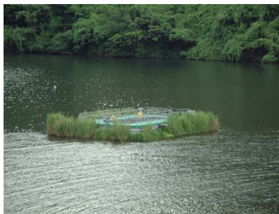
写真 2.2.4 耶馬溪ダム水質保全装置 (深層曝気設備)
