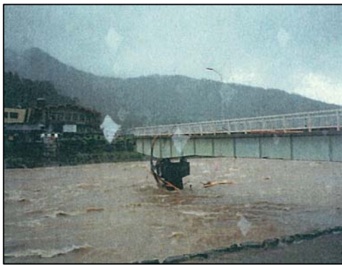
写真 1.2.2 曾木地区(橋の流失)増水状況 (平成 5 年 9 月)
