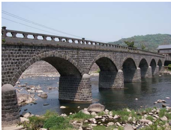
写真 2.3.7 耶馬溪橋（オランダ橋）
