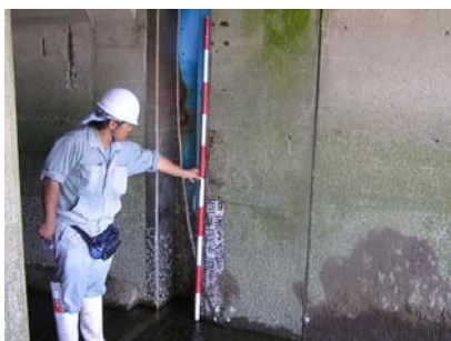
写真 2.1.2 樋門・樋管等の点検状況
