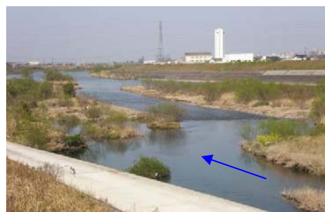
土砂撤去及び樹木伐採後
