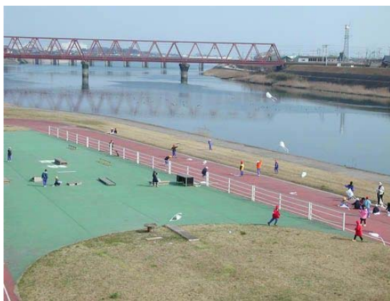
写真 4.2.1 河川利用状況（幸子地区）
