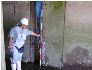
写真2.1.2 樋門・樋管等の点検状況
