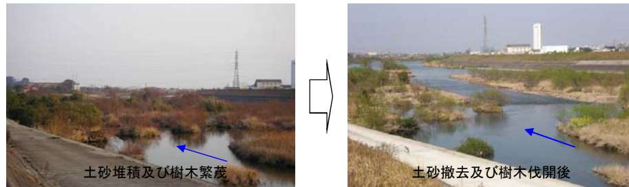
写真4.3.2 河道内樹木管理（平成大堰下流）
