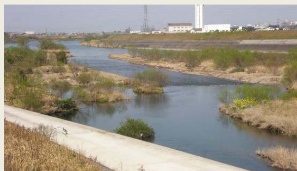
土砂撤去及び樹木伐採後
