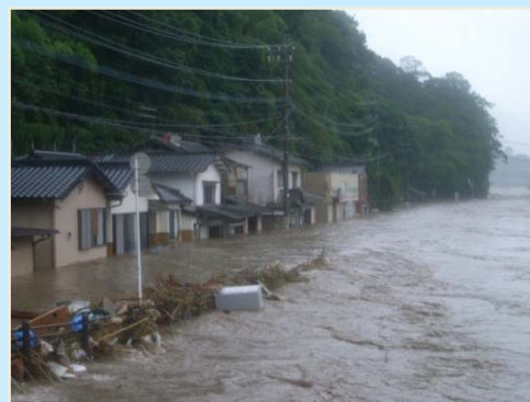
山国川中流部の浸水状況 (平成24年7月)
