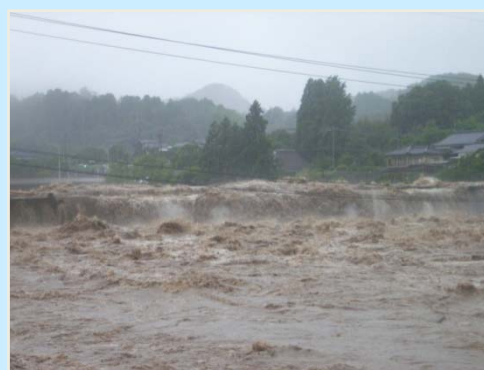
耶馬溪橋付近増水状況 (平成24年7月)
