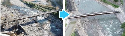
老朽化した橋を頑丈な構造にしたり、橋脚の数を減らし、洪水時の破損や流木による閉塞を防ぎます。
