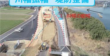
川幅の拡幅・堤防整備等により、洪水を流れやすくします。
