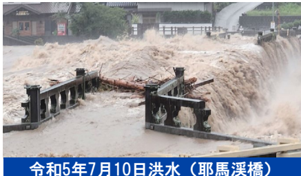
令和5年7月10日洪水（耶馬溪橋）
