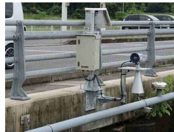
危機管理型水位計設置状況
