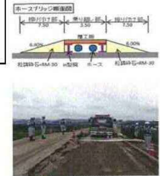
排水ホース上を車両が通行するための対策例(ホースブリッジ) (H26年8月豪雨(中国地整))
