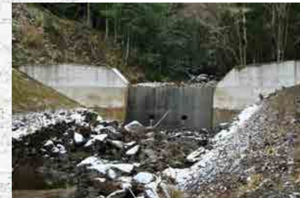
土砂を捕捉した治山ダム
