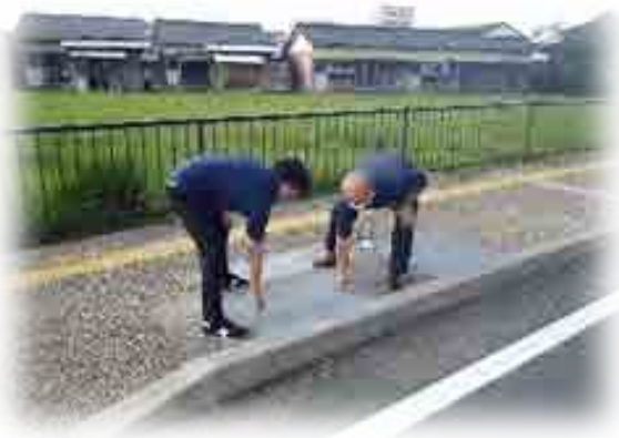
職員による水路ゲート操作状況
