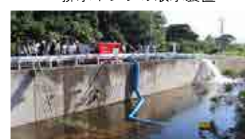
排水ポンプの取水装置
