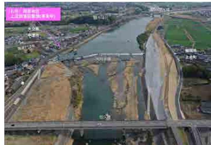
相原地区築堤護岸工事
