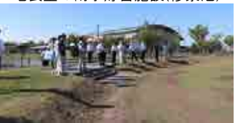
地表型の雨水貯留施設 (多目的広場)
