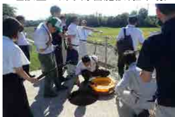
雨水貯留施設の排水管
