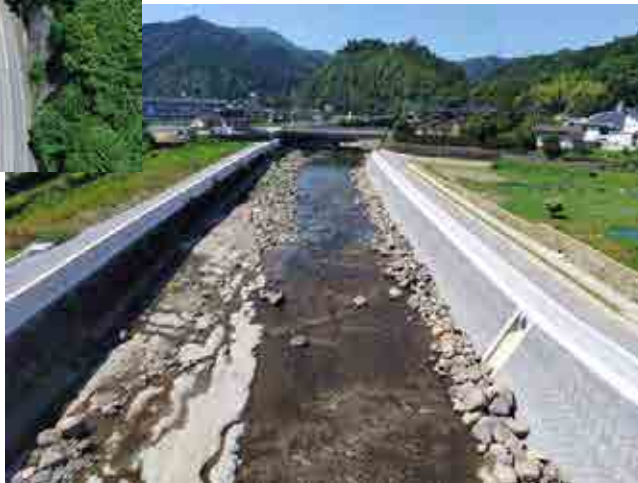
金吉川の特設堤工
