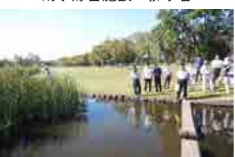
地表型の雨水貯留施設(修景池)
