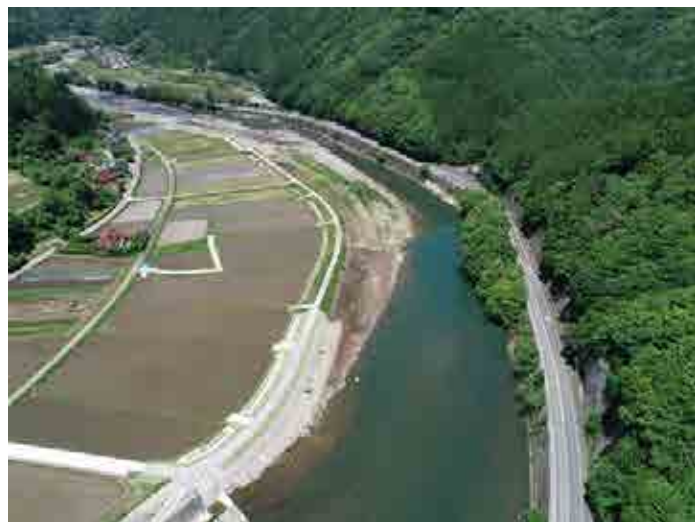
山国川の河道掘削、護岸工
