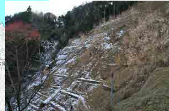
土砂を捕捉した治山ダム
