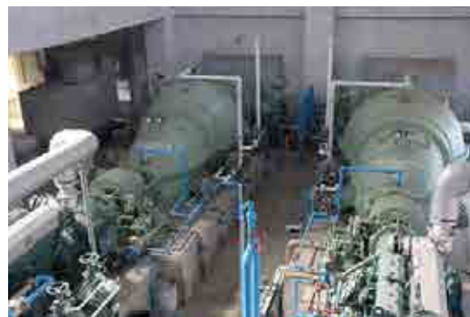
農業用水路兼雨水排水路の排水機による強制排水(吉富排水機場)
