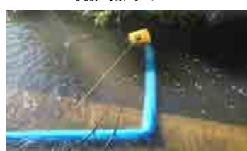
排水ポンプの取水装置
