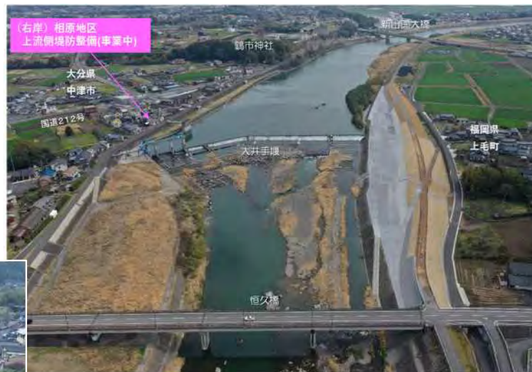
相原地区築堤護岸工事
