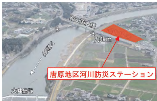
唐原地区河川防災ステーション
