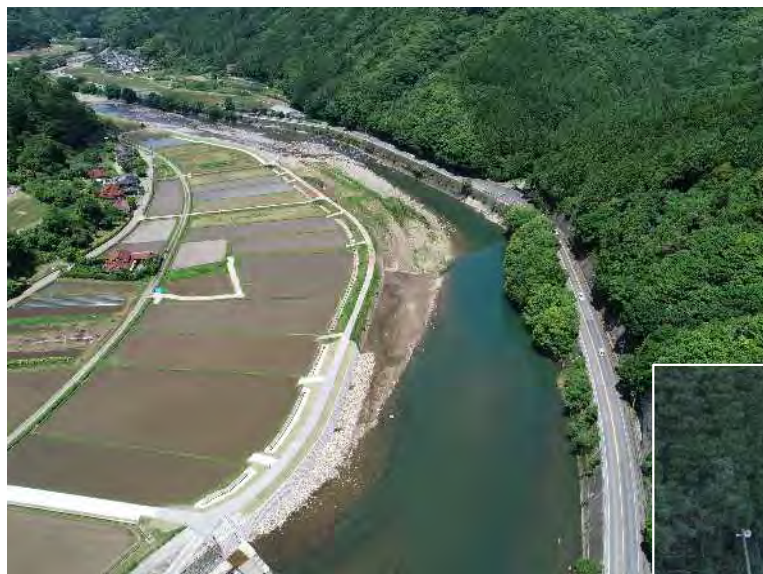
山国川の河道掘削、護岸工
