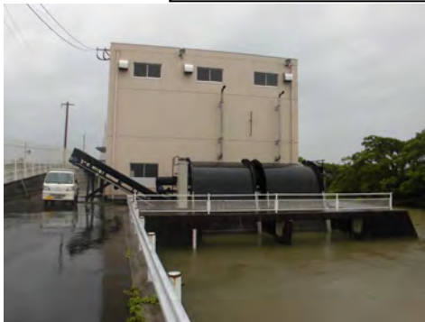
農業用水路兼雨水排水路の排水機による強制排水(吉富排水機場)
