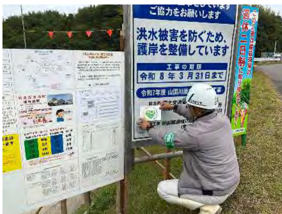
原井地区護岸整備(国)
