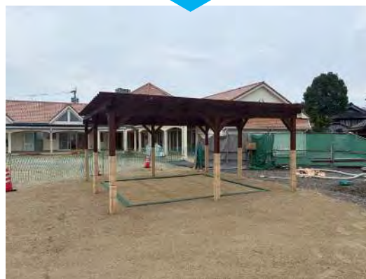
豊田幼稚園雨水貯留施設整備
