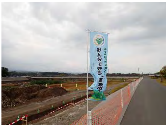
相原地区堤防整備(国)
