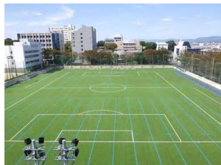
久留米大学雨水貯留施設
