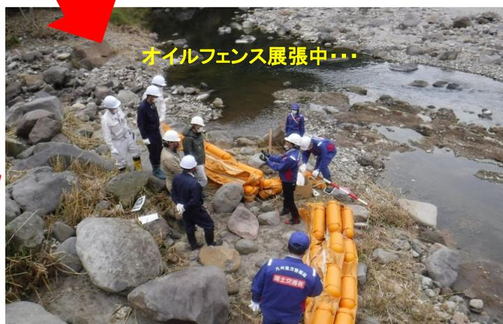
オイルフェンスを水面に張り、下流に油が流れ出ないようにせき止めます
