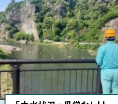
「内水状況=異常なし!!」
