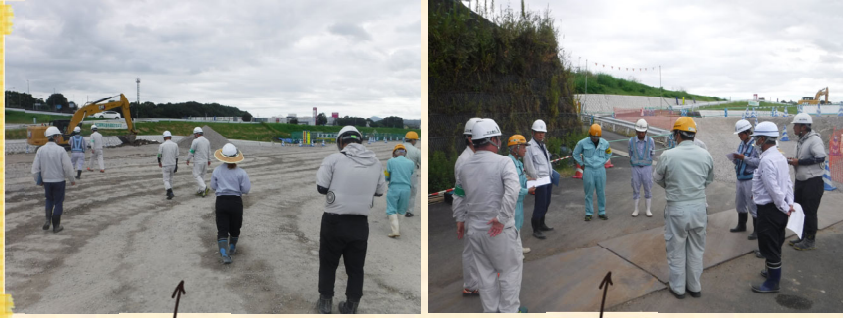
施工業者の皆さんと現場点検
