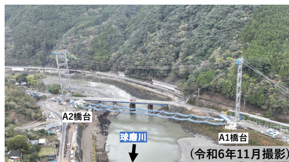
鎌瀬橋の工事状況
