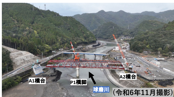
坂本橋の工事状況
