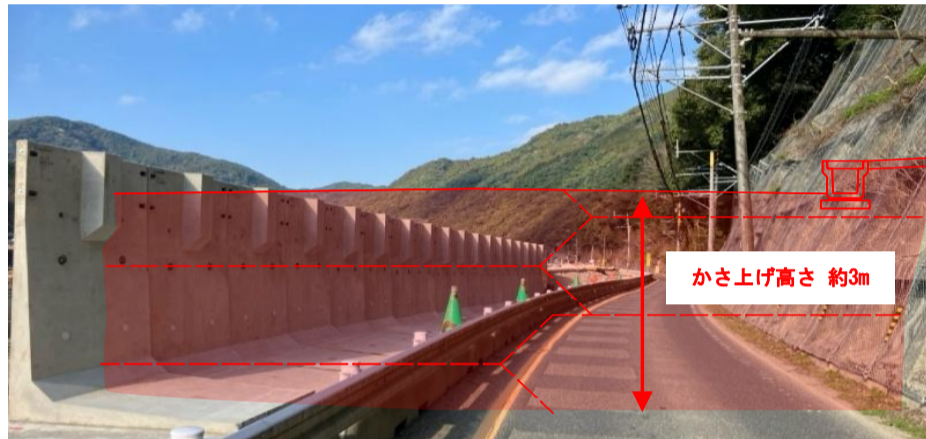
道路かさ上げ工事
