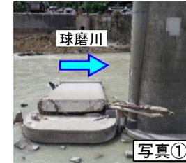
写真① 坂本橋側道橋P1橋脚の転倒、柱基部の鉄筋破断
