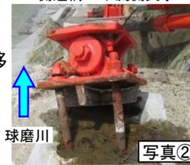
写真② アンカーボルトの引き抜け
