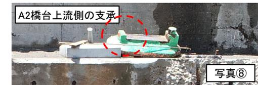
サイドブロック爪部の破断
