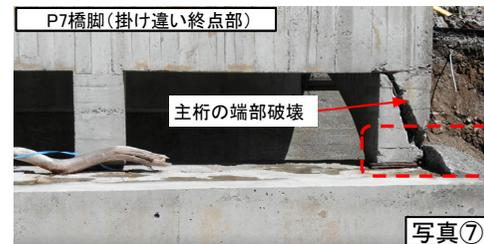
パッド型ゴム支承が残存(橋座端部の欠けなし)
