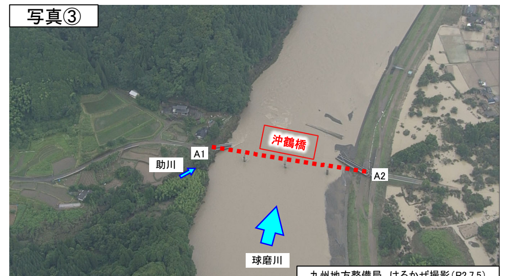
九州地方整備局 はるかぜ撮影(R2.7.5)
