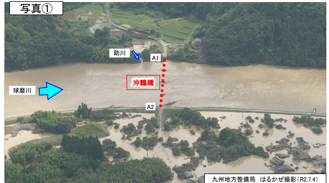
九州地方整備局 はるかぜ撮影(R2.7.4)
