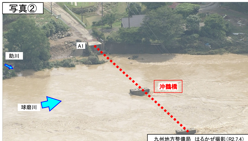
九州地方整備局 はるかぜ撮影(R2.7.4)
