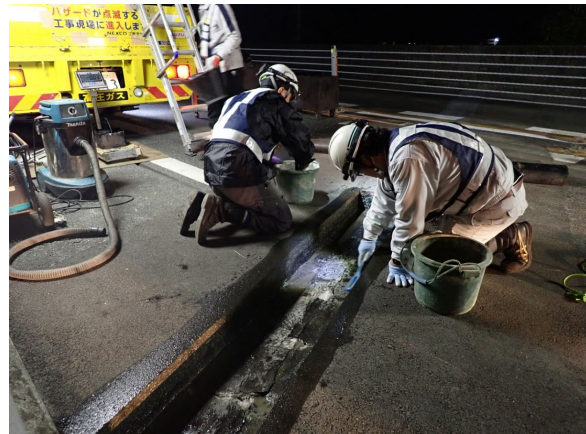
<伸縮装置取替>
