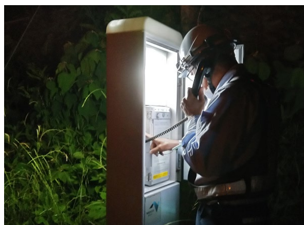
<非常電話設備点検>
