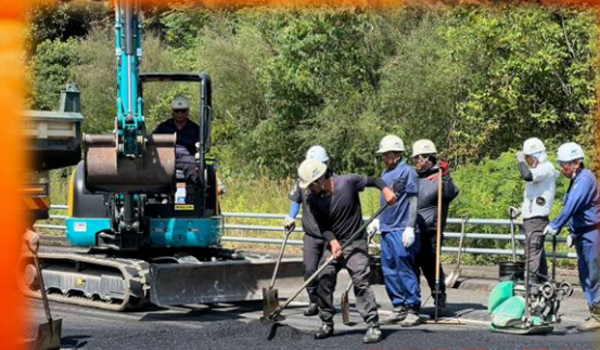
復旧作業の様子
