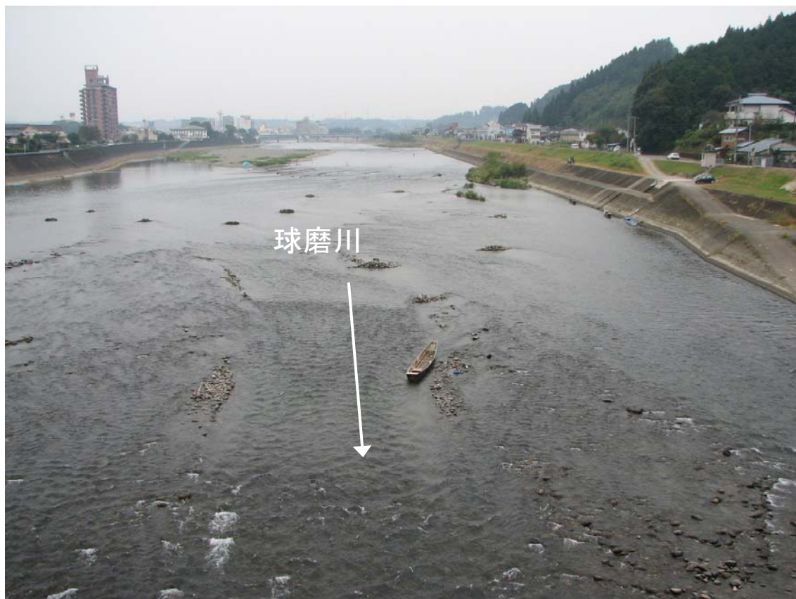
河道掘削により消失する産卵場(織月大橋上流付近)
