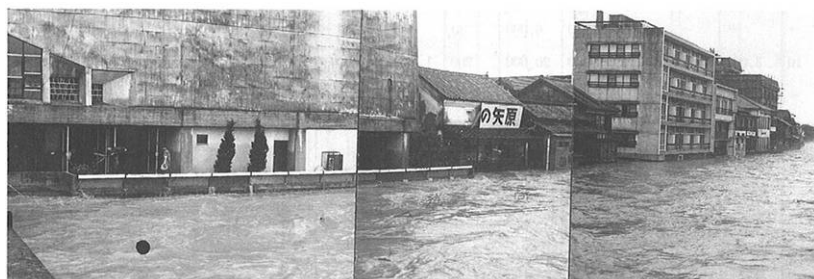
人吉橋上流市街地の浸水状況(人吉市)
