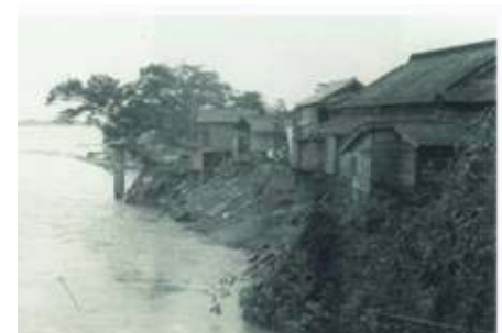
球磨川下流部の被災状況(八代市)
