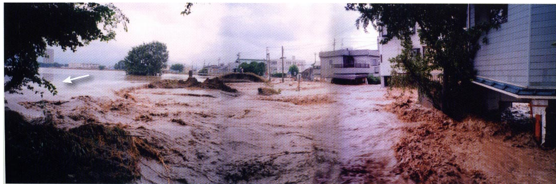
越水により堤防が決壊した事例
