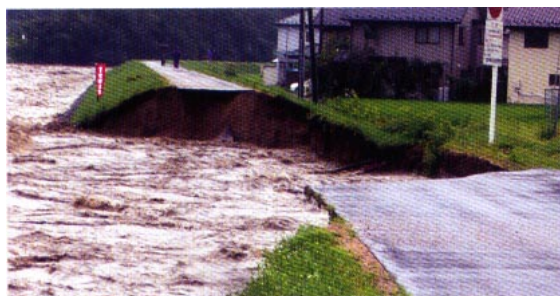
越水していなくても堤防が決壊した事例
