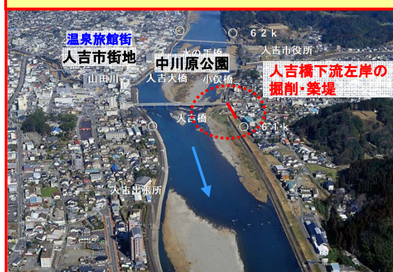
人吉橋下流左岸の掘削・築堤
