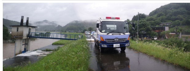
排水ポンプ車稼働状況 (2011年6月19日) (渡第二樋管)
