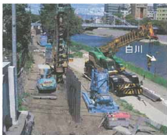
堤防の中に鋼矢板が打ち込まれる熊本市の白川 2012.8.25 撮影
