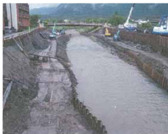
堤防の中に鋼矢板が打ち込まれた 阿蘇・内牧の黒川 2014.8.4 撮影
