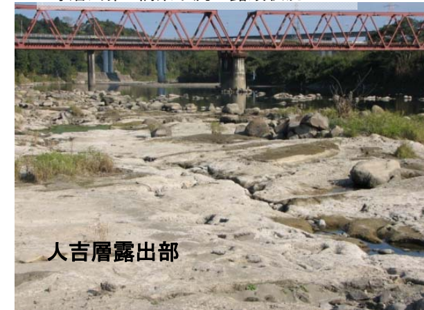
球磨川第3橋梁下流の露頭状況
