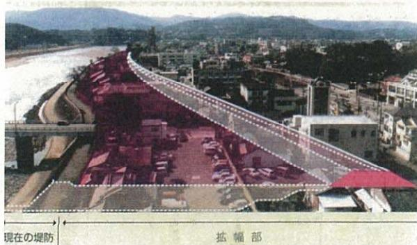
国土交通省資料「球磨川水系の治水について」(平成13年10月)の引堤案。毎秒7000m<sup>3</sup>の洪水を目標にしている
