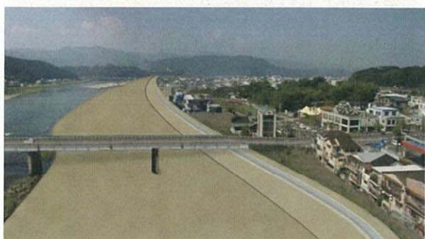
国土交通省が今回提示した引堤案。毎秒5300m<sup>3</sup>を目標流量としているのに、毎秒7000m<sup>3</sup>を目標としていた住民討論集会時と同じ規模の改修後のイメージ写真を提示している
