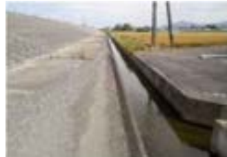
堤脚部の幅が広く排水作業が可能(球磨川左岸0k800付近)
