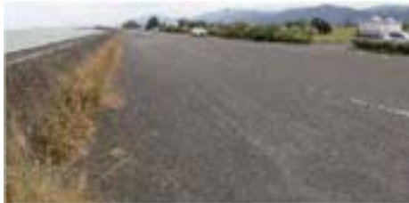
堤防天端幅が広く排水ポンプ車等の設置が可能な状況(球磨川左岸0k300付近)
