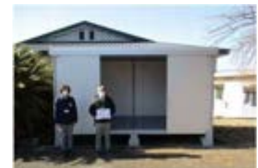
防災倉庫の整備（多良木町）
