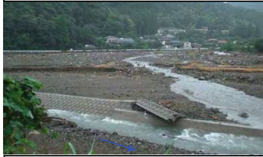
吉尾川・護岸一部欠損
