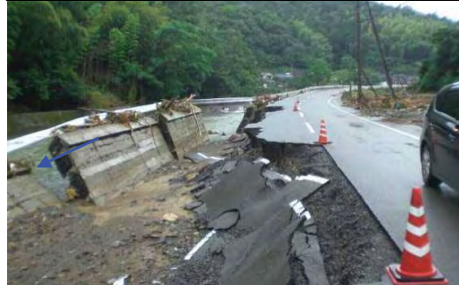
吉尾川・護岸一部欠損
