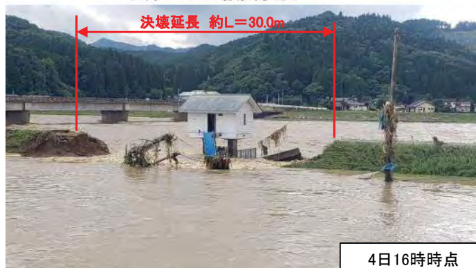
右岸56k400被災状況
