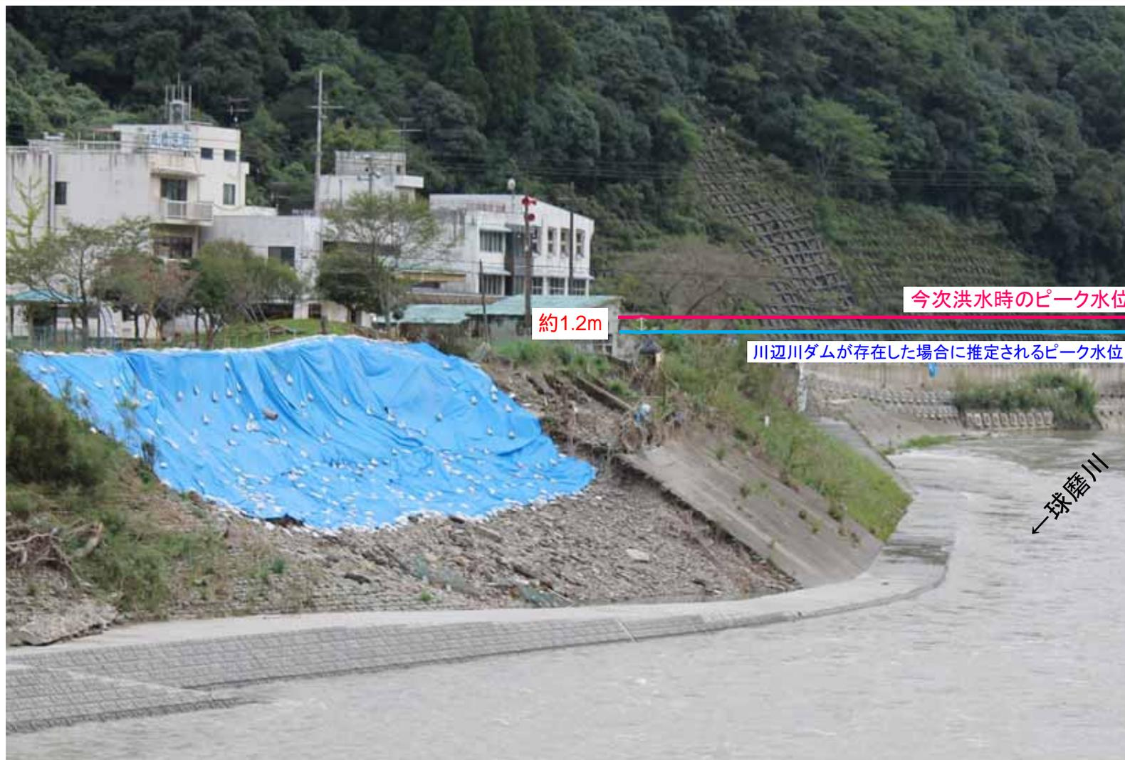
○仮に川辺川ダムが存在した場合を想定し、「八代市坂本町大門地区(球磨川18k800付近)」の川辺川ダム洪水調節後のピーク水位を算定すると、河道の水位が今次洪水に比べ約1.2m程度低下すると推定される。
