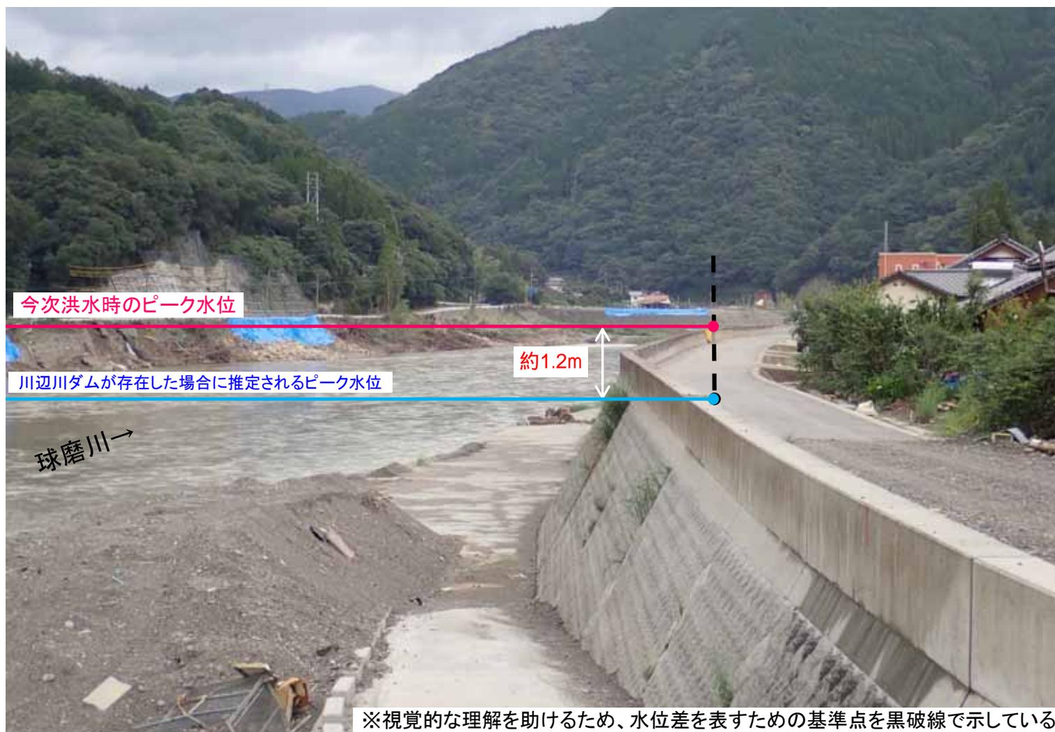
○仮に川辺川ダムが存在した場合を想定し、「八代市坂本町荒瀬地区(球磨川19k200付近)」の川辺川ダム洪水調節後のピーク水位を算定すると、河道の水位が今次洪水に比べ約1.2m程度低下すると推定される。
