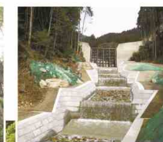
北目川砂防堰堤(水上村)
