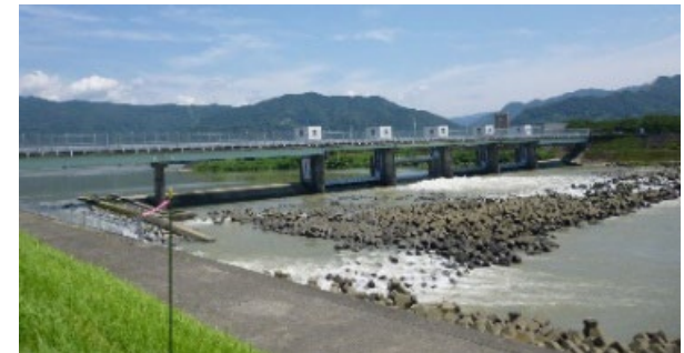
新前川堰の魚道
