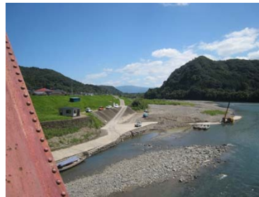
河道に堆積する土砂
