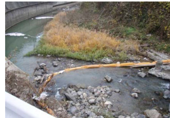
水質事故対策(オイルフェンスの設置)
